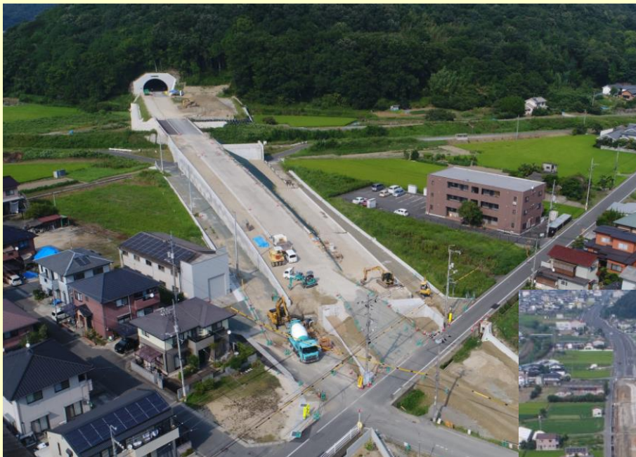
【8月末の工事状況】
