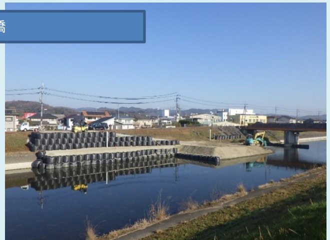
(工事の状況：令和3年12月)
