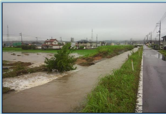
〔平成30年7月 被災状況〕
