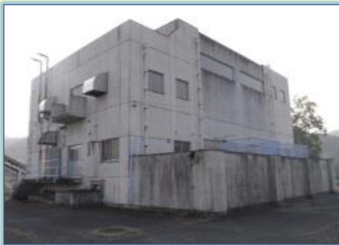
〔古市排水機場〕
