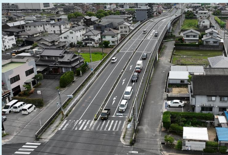
(徳田陸橋東詰交差点)
