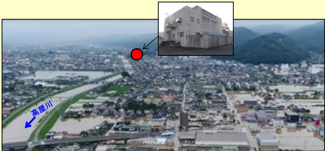
〔古市排水機場〕
