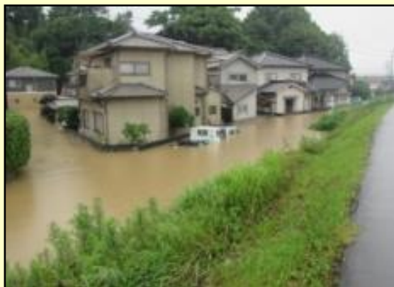
〔平成 30 年 7 月豪雨 浸水状況〕
