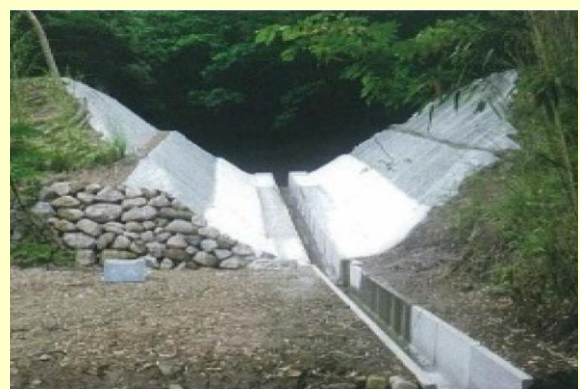
〔ため池の廃止〔堰堤解体〕〕
